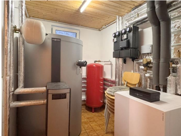
Wärmepumpe mit Erdwärme
