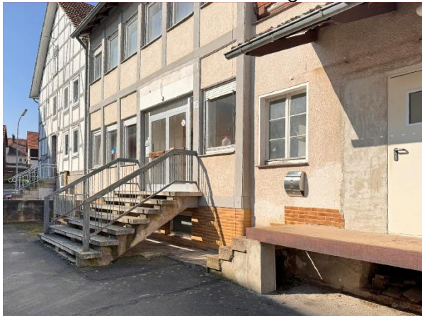
Gebäude 1 – Büro- oder Wohngebäude:
